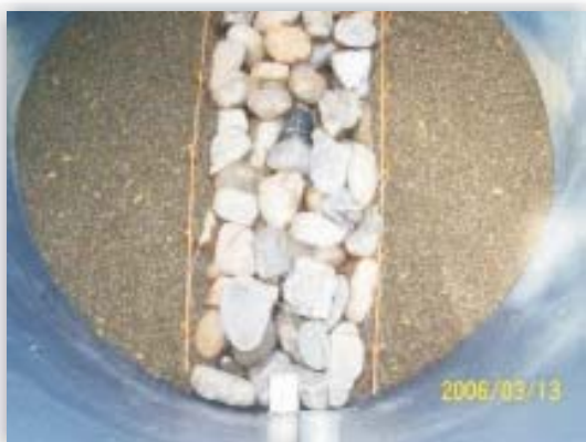
“Segundo tanque con triturado de ¼ de pulg y tercer tanque con carbón activado”
