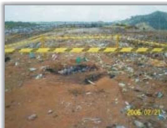
Delimitación de vías internas y área de trabajo con cinta reflectiva
