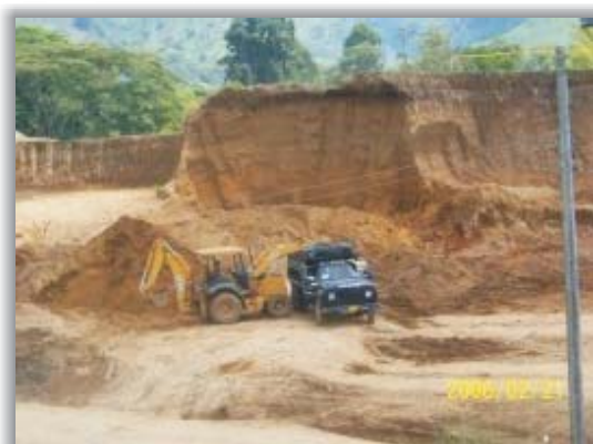
Adecuación vaso No. 5
