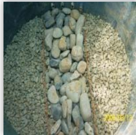
“Primer tanque con anejo y filtro en triturado de 1Pulg”
