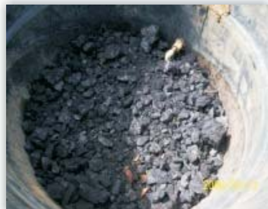
“Segundo tanque con triturado de ¼ de pulg y tercer tanque con carbón activado”
