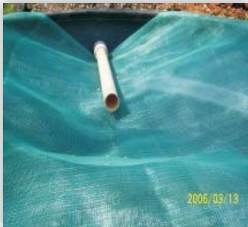
“Primer tanque con anejo y filtro en triturado de 1Pulg”
